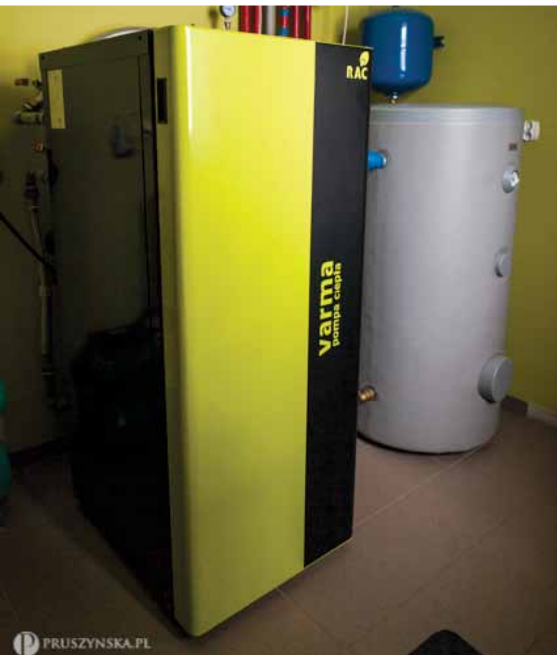
Instalacja pompy ciepła nie zajmuje dużo miejsca.
